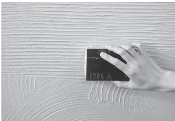
スポンジの凹凸を使って仕上げた例
