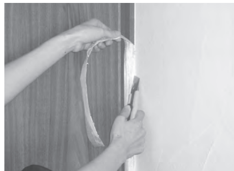
仕上げヘラ「スムーディ」で平滑に仕上げた例
