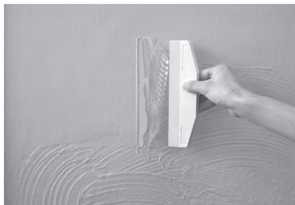
仕上げヘラ「スムーディ」で平滑に仕上げた例
